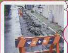
駿河湾を震源とする地震によるブロック塀の倒壊
